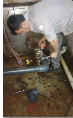
Sirkülasyon, santrifüj ve dalgıç pompaların dönemsel bakımları tamamlanmıştır.
