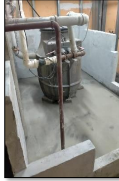
Dalgıç pompaların periyodik bakımları ve pis su hijyenik pompaları ile tesisatları yeni imalat çalışmaları
