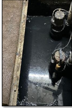
Dalgıç pompaların periyodik bakımları ve pis su hijyenik pompaları ile tesisatları yeni imalat çalışmaları
