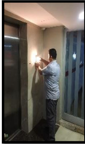
Site geneli ortak alanlardaki aydınlatma linye arızaları, armatür onarım ve lamba değişimleri yapılmıştır.
