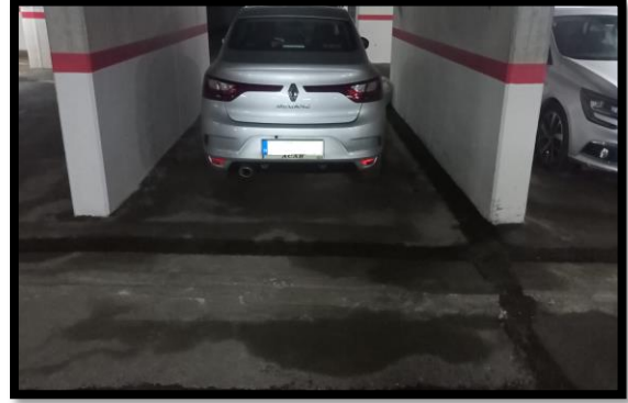
Bodrum 3. Kat kapalı otopark alanının zemin düzenlenmesi işleri tamamlanmıştır.
