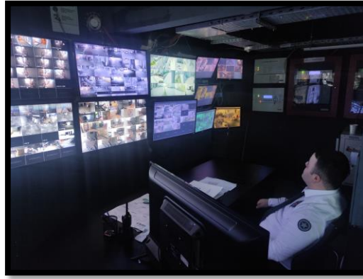
Güvenlik kontrol merkezi 7/24 izlemeleri
