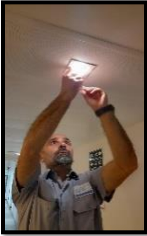
Site geneli ortak alanlardaki aydınlatma linye arızaları, armatür onarım ve lamba değişimleri yapılmıştır.
