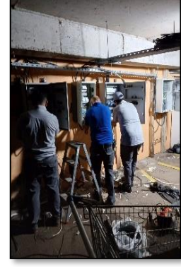
Havuz makine dairesi havuz sirkülasyon pompaları MCC panoları modernizasyon çalışmaları
