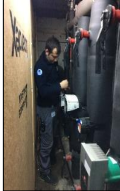
Sirkülasyon, santrifüj ve dalgıç pompaların dönemsel bakımları tamamlanmıştır.
