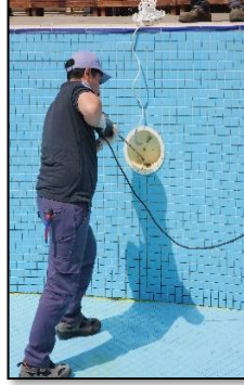
A k havuz aydınlatma sistemi tesisat ve revizyon  alıřmaları
