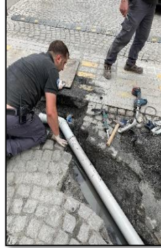
Drenaj ve yağmur suyu tesisatları ilave imalat çalışmaları
