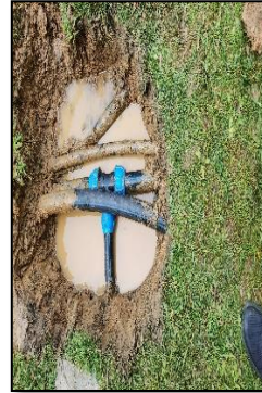
Açık bahçe alanları toprak altı bahçe sulama tesisat kaçakları ve onarım işleri
