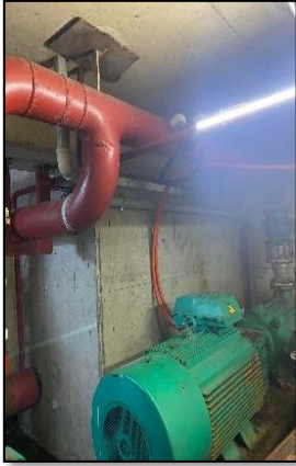
Blokların yangın sulu söndürme pompa gruplarının periyodik bakımları ve çalışma testleri
