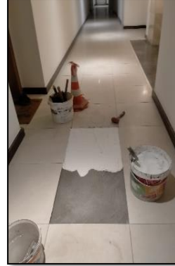
Blok katları kapalı ve açık alan sert zemin onarım ile izolasyon çalışmaları
