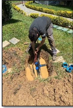
Açık bahçe alanları toprak altı bahçe sulama tesisat kaçakları ve onarım işleri
