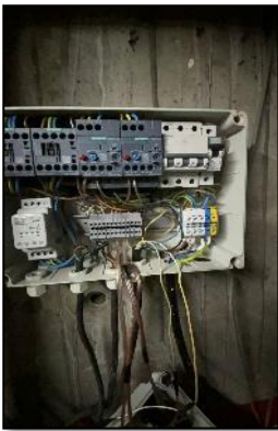
Garaj katlarında bulunan zemin suyu toplama çukurlarındaki pompaların pano revizyon çalışmaları
