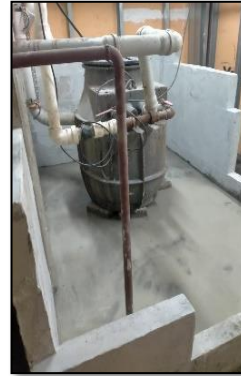
Dalgı pompaların periyodik bakımları ve pis su hijyenik pompaları ile tesisatları yeni imalat alıřmaları
