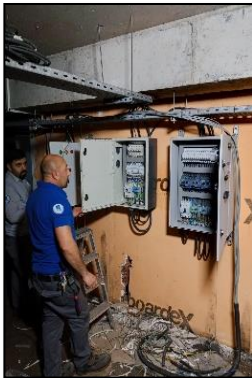
Havuz makine dairesi havuz sirkülasyon pompaları MCC panoları modernizasyon çalışmaları
