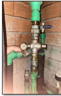
Sıcak ve soğuk tesisatları ölçme ile basınç düşürücü arıza bakım çalışmaları
