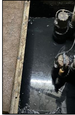
Dalgı pompaların periyodik bakımları ve pis su hijyenik pompaları ile tesisatları yeni imalat alıřmaları
