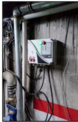
Garaj katlarında bulunan zemin suyu toplama çukurlarındaki pompaların pano revizyon çalışmaları
