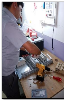
Havuz makine dairesi havuz sirkülasyon pompaları MCC panoları modernizasyon çalışmaları
