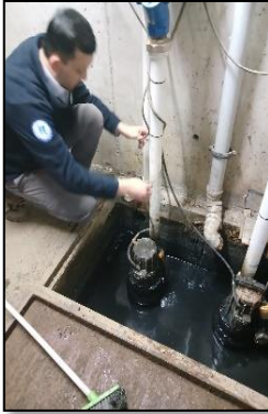
Dalgı pompaların periyodik bakımları ve pis su hijyenik pompaları ile tesisatları yeni imalat alıřmaları
