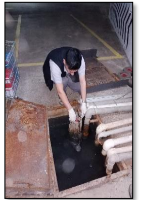
Garaj katlarında bulunan zemin suyu toplama çukurlarındaki pompaların pano revizyon çalışmaları
