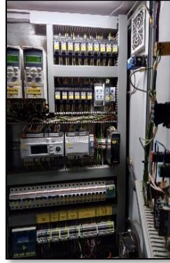
Ortak alanlar Dağıtım, MCC, Otomasyon Panoları Bakımları
