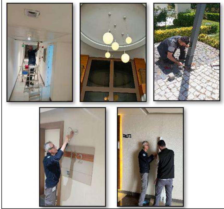
Site geneli ortak alanlardaki aydınlatma armatür onarım ve lamba değişimleri yapılmıştır.
