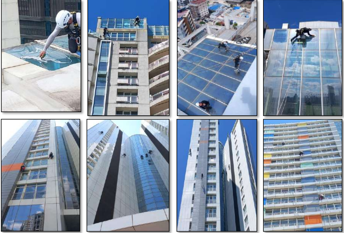
Dış cephe kompozit, cam ve iç cephe cam temizliklerinden Dağcılar ile yapılan temizlik çalışmalarının ilki dönem içerisinde yapılmıştır.
