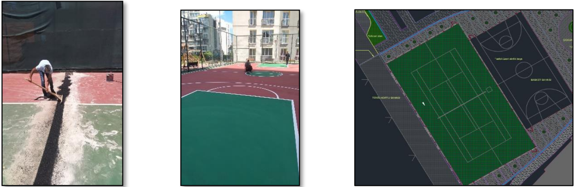
Tenis kortu zemin yenileme ve üst file koruma filesi uygulamaları tamamlanmıştır.
