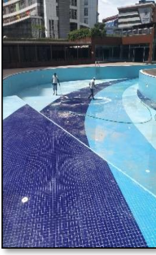
Açık - kapalı havuz seramik ve derz değişimleri yapılarak, aydınlatma tesisatı revize edilmiştir.
