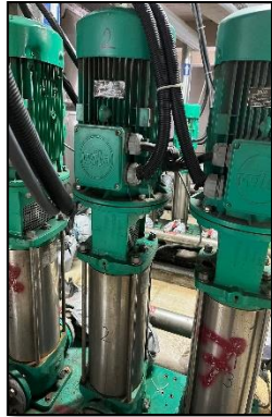
Sirkülasyon, dalgıç ve hidrofor grubu pompalarının arıza ile periyodik bakımları dönem içinde yapılmıştır.
