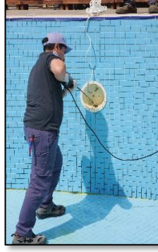
Açık - kapalı havuz seramik ve derz değişimleri yapılarak, aydınlatma tesisatı revize edilmiştir.
