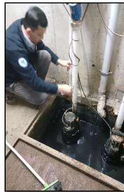
Sirkülasyon, dalgıç ve hidrofor grubu pompalarının arıza ile periyodik bakımları dönem içinde yapılmıştır.
