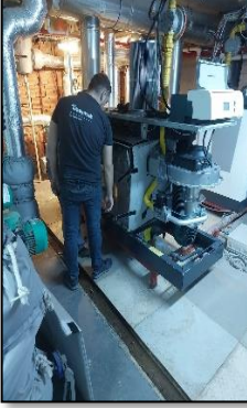
Sıcak su kazanları periyodik bakımları ve baca gazı emisyon ölçümleri tamamlanmıştır.
