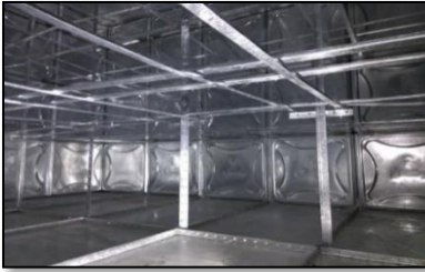
Paslanmaz kullanma suyu depolarının temizlik, bakım ve dezenfeksiyon çalışmaları
