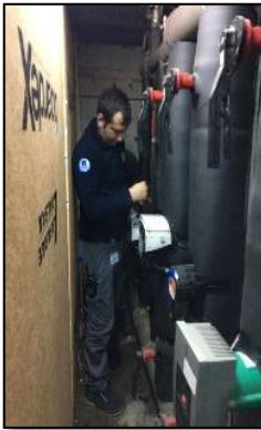
Sirkülasyon, dalgıç ve hidrofor grubu pompalarının arıza ile periyodik bakımları dönem içinde yapılmıştır.
