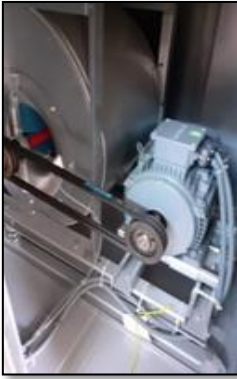
Havalandırma santralleri ve ortak alanlardaki fanların periyodik bakımları dönem içinde aylık bazda yapılmıştır.
