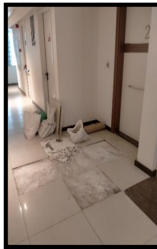
Asansör kat holleri zemin seramikleri ve garaj duvar sıva çalışmaları devam etmektedir.
