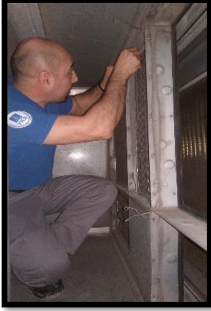
Havalandırma santralleri kaset filtrelerin aylık değişim ve temizlikleri yapılmıştır.
