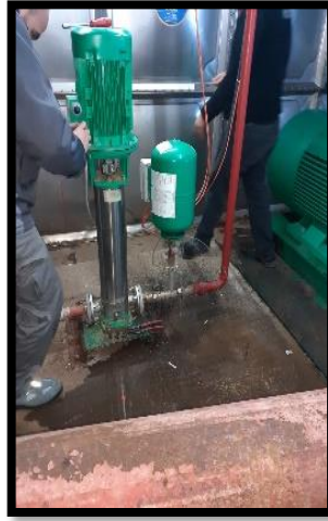
Blokların yangın sulu söndürme pompa gruplarının periyodik bakımları ile A blok jokey pompa testleri yapılmıştır.
