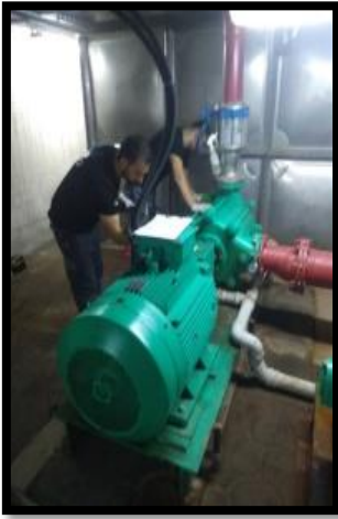
Blokların yangın sulu söndürme pompa gruplarının periyodik bakımları ile A blok jokey pompa testleri yapılmıştır.
