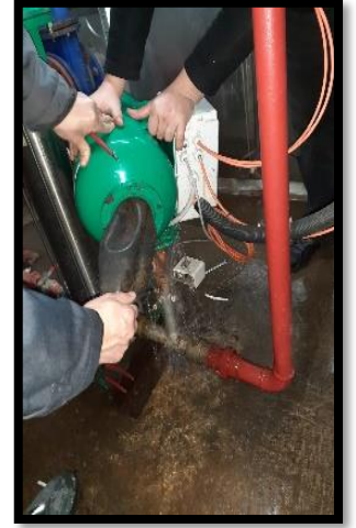
Blokların yangın sulu söndürme pompa gruplarının periyodik bakımları ile A blok jokey pompa testleri yapılmıştır.
