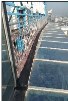
A blok Çatı , B-C-D ortak teras ve 28. Kat teras zemin su izolasyon problemleri çözülmüştür.
