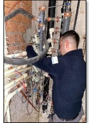
Sıcak ve soğuk tesisatları ölçme ile düşürücü elemanların bakım ile değişimleri yapılmıştır.
