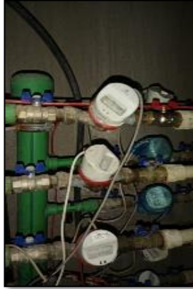
Sıcak ve soğuk tesisatları ölçme ile düşürücü elemanların bakım ile değişimleri yapılmıştır.
