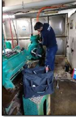
Blokların yangın sulu söndürme pompa gruplarının periyodik bakımları çalışmaları ve testleri tamamlanmıştır.
