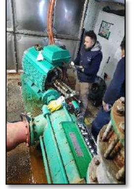
Blokların yangın sulu söndürme pompa gruplarının periyodik bakımları çalışmaları ve testleri tamamlanmıştır.
