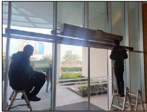
B-C-D blok resepsiyon giriş kayar kapı mekanizmaları modernize edilmiştir.
