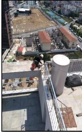
B-C-D blok üst teras bölgelerindeki dekoratif kemer ve başlıklarının sıva onarımları yapılmıştır.
