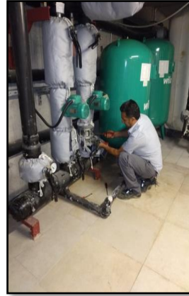
Dalgıç, sirkülasyon, drenaj ve santrifüj pompaların periyodik minör bakımları yapılmıştır.
