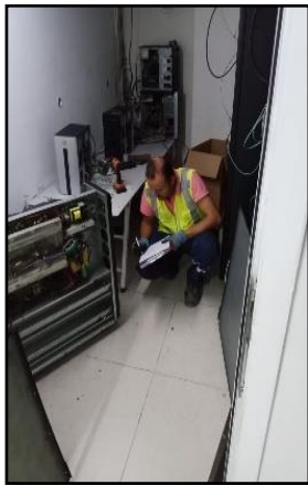
AG, MCC ve DDC pano bakımları dönem içerisinde tamamlanmıştır.
